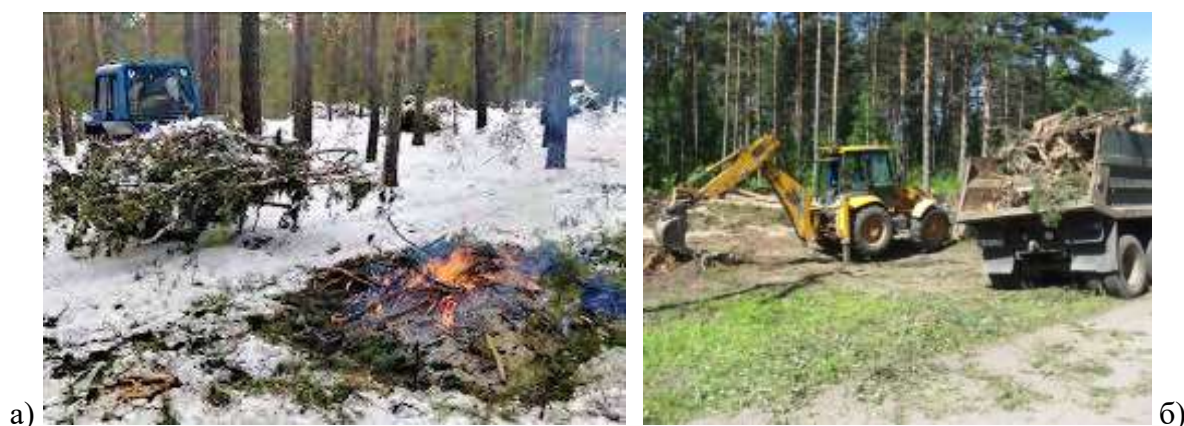
а) грабли Himac Tractor Stick Rakes + трактор Massey Ferguson 945 б) грабли Erskine Skid Steer Industrial Grapple Rake + многофункциональная машина Cat + транспортное средство Рисунок 1 – Технологическая операция уборки порубочных остатков
