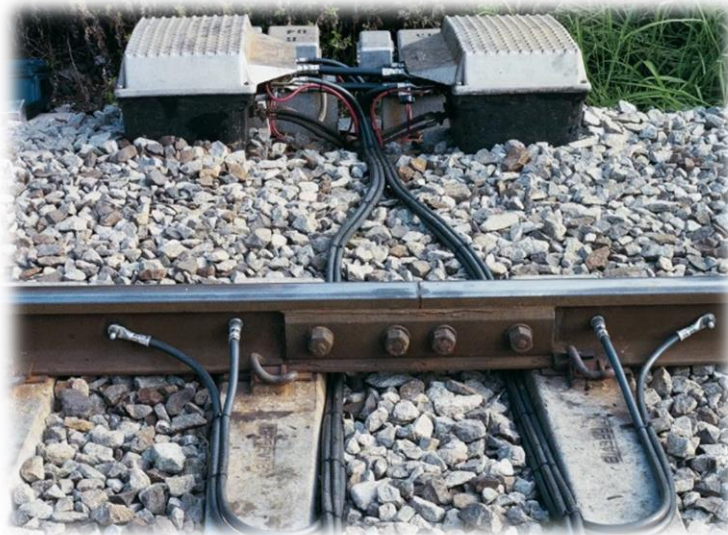
Рисунок 1 – Соединение сигнальных и тяговых цепей
