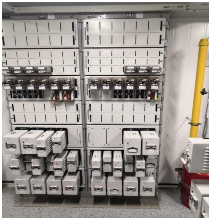
Рисунок 2 – Статив электрической централизации
