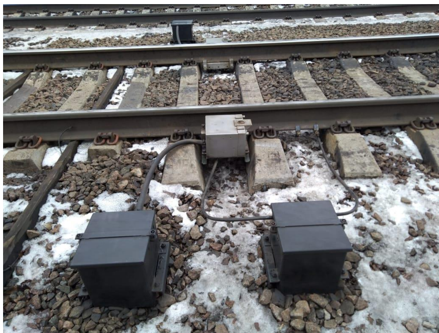
Рисунок 2 - Камеры напольные малогабаритные КНМ-05 с приемником ИК излучения для подсистем КТСМ-02БТ
