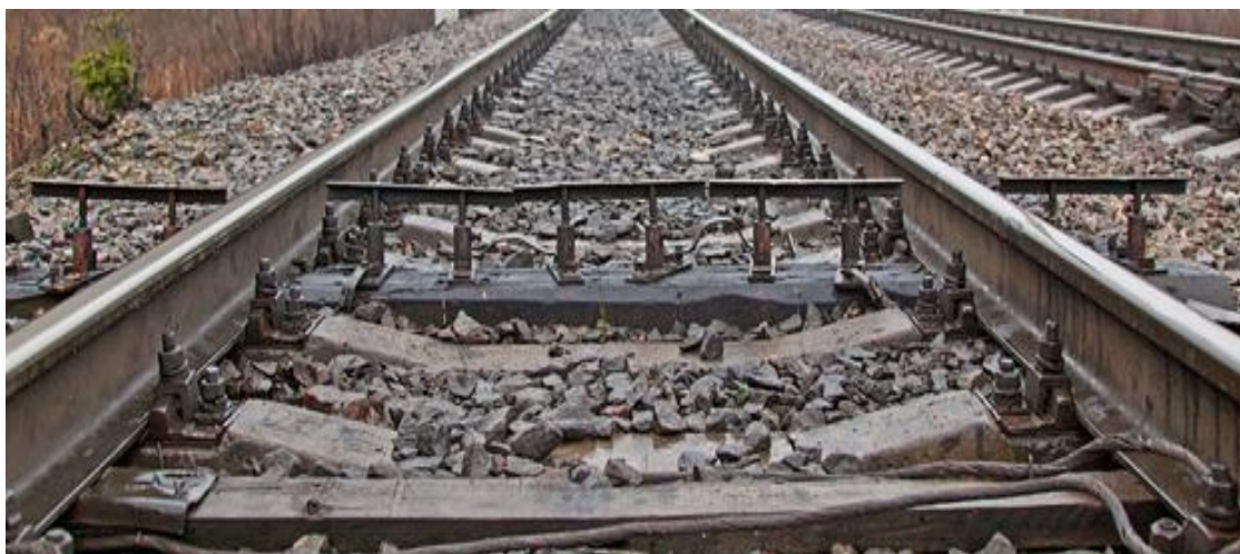
Рисунок 5 - Устройство контроля схода подвижного состава
