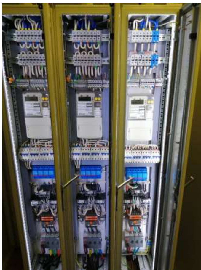
Рисунок 2 - Устройство ввода и защиты фидера
