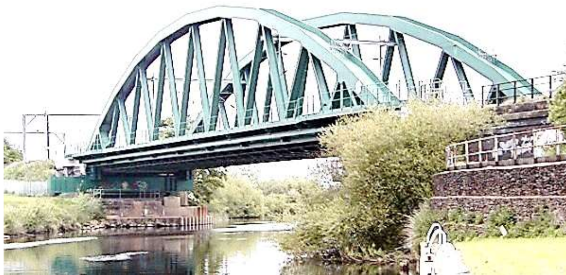
Рисунок 3 – Металлический железнодорожный мост
