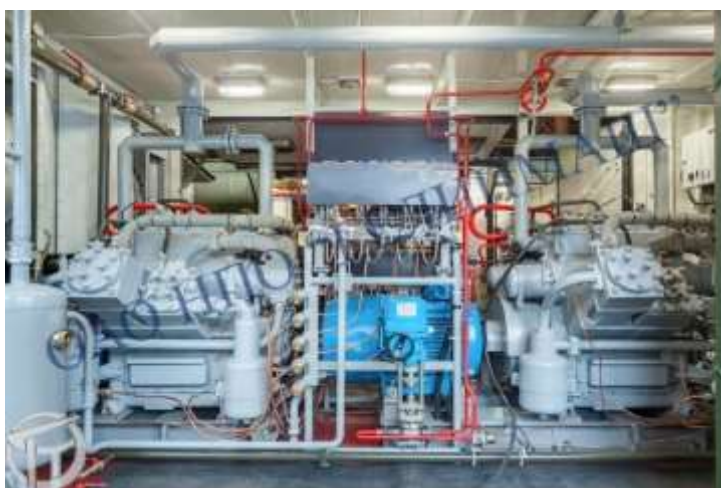
Рисунок 2 — Электродвигатель установленный в компрессорном отделении ТКДС-100В.
