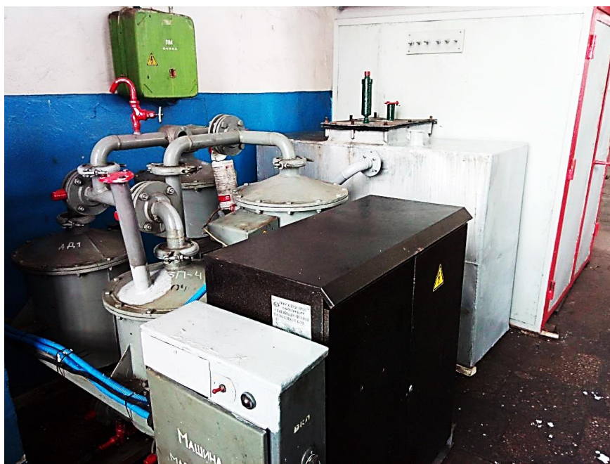
Рисунок 1. Общий вид цеолитовой установки с доработками
