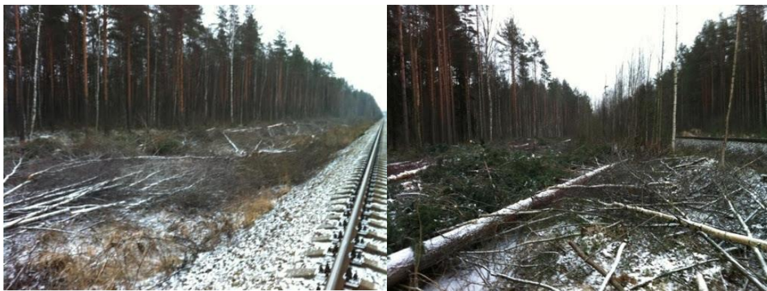
Рисунок 1 – Порубочные остатки в полосе отвода железной дороги
