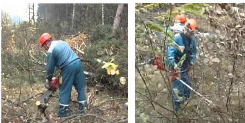
Рисунок 2 – Расчистка просек ЛЭП
