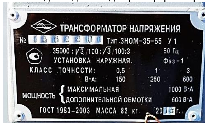
Рисунок 2. Технические характеристики трансформатора напряжения ЗНОМ-35-65У1
