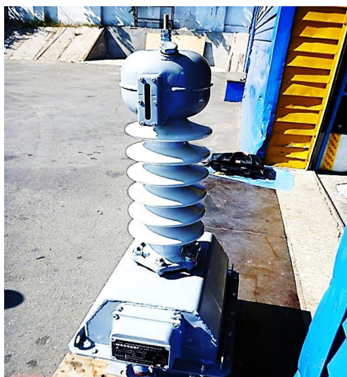
Рисунок 1. Внешний вид трансформатора напряжения ЗНОМ-35-65У1
