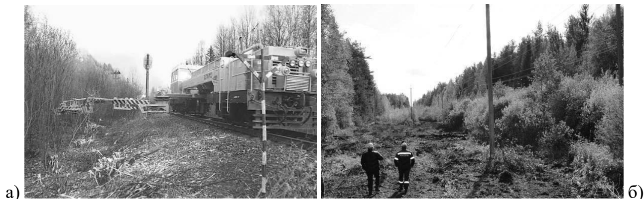
Рисунок 1 – Выполнение работ по удалению нежелательной растительности а) в полосе отвода железных дорог, апрель 2019 г. б) в охранной зоне высоковольтной линии, сентябрь 2014 г.
