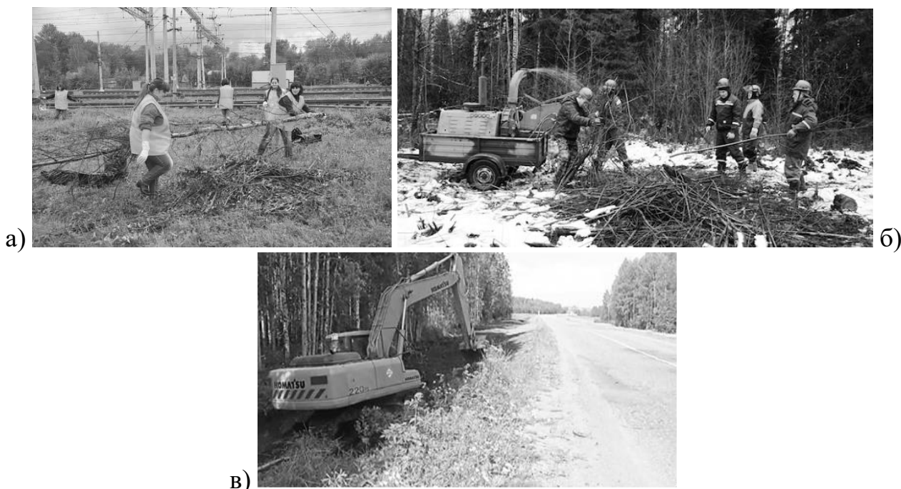
Рисунок 1 – Выполнение работ по удалению нежелательной растительности
