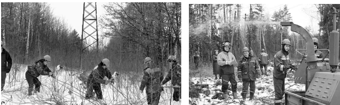
Рисунок 1 – Удаление нежелательной растительности в охранной зоне ВЛ
