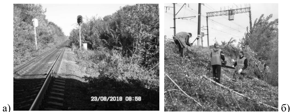
Рисунок 1 – Борьба с нежелательной растительностью в полосе отвода железных дорог
