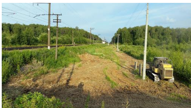
Рисунок 1 – Расчистка полосы отвода железных дороги самоходными мульчерами
