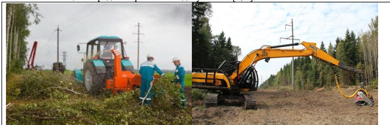
Рисунок 1 – Расчистка просек линий электропередач от нежелательной растительности с применением:
