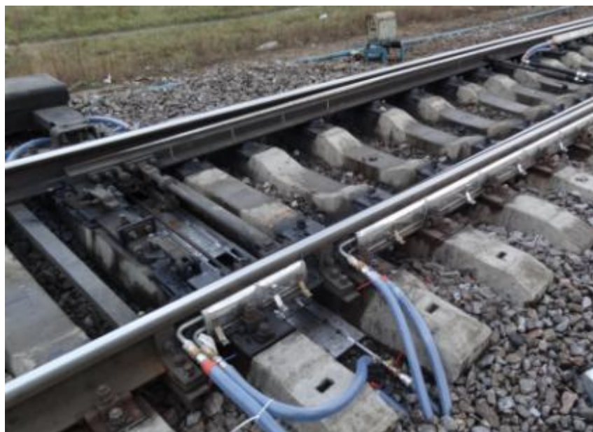
Рисунок 3. Система геотермического обогрева стрелочного перевода
