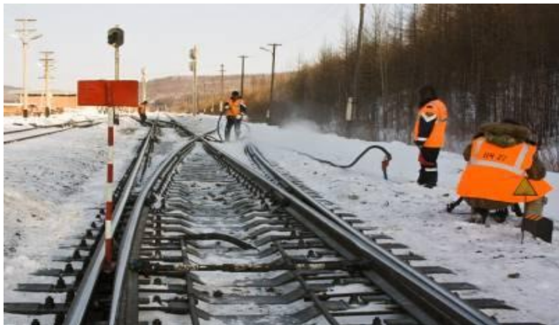
Рисунок 1. Стационарные устройства пневмоочистки стрелок от снега и устройства ручной шланговой пневмообдувки.
